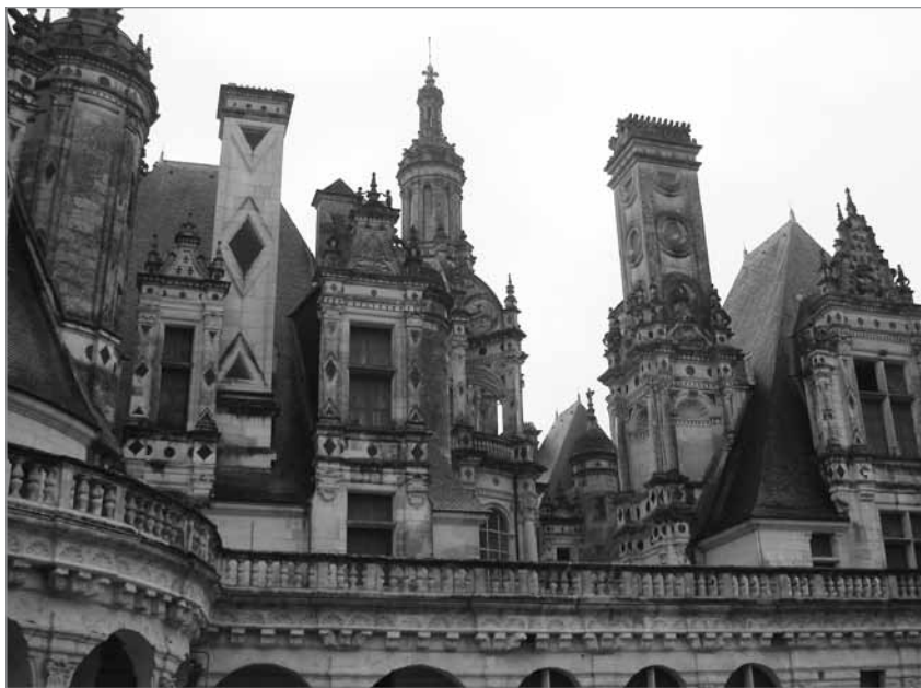
Ил. 9. Замок Шамбор. 1519–1547. Часть кровли
