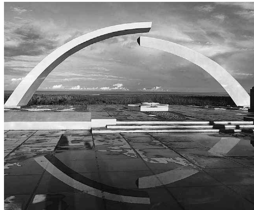
1. Константин Симун. Разорванное кольцо . 1965–1966 Железобетон. 900 × 1200 × 2500
