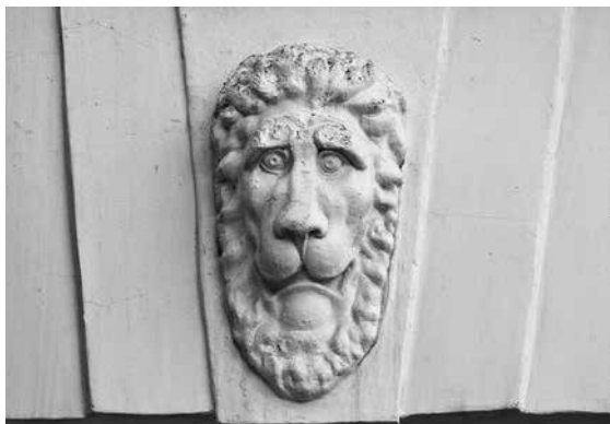
12. Маскарон Лев . Усадьба Усачёвых-Найденовых на ул. Земляной Вал 1829–1831
